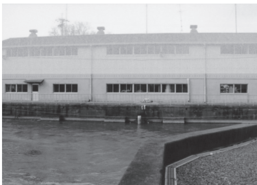
写真2 木屋揚水機場
