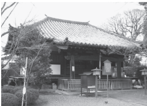
写真 25 北野経王堂（大報恩寺境内 京都市上京区）
