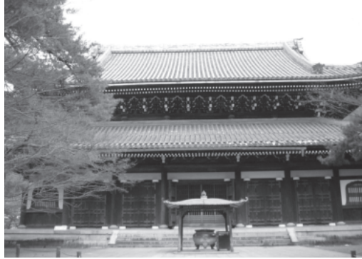
写真 15 南禅寺法堂（京都市左京区）
