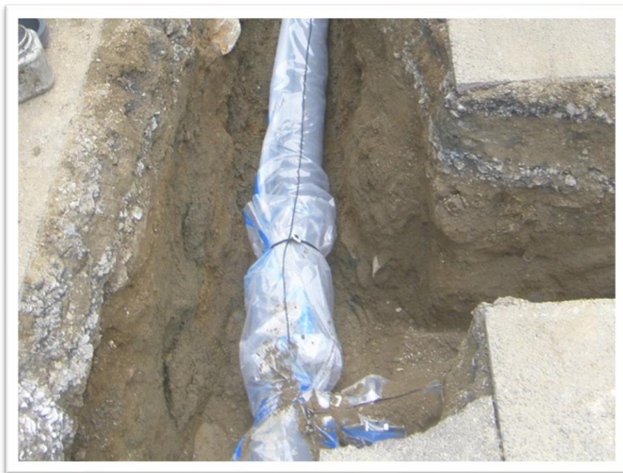
耐震管への布設替え工事の様子
