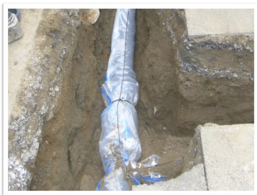
耐震管への布設替え工事の様子
