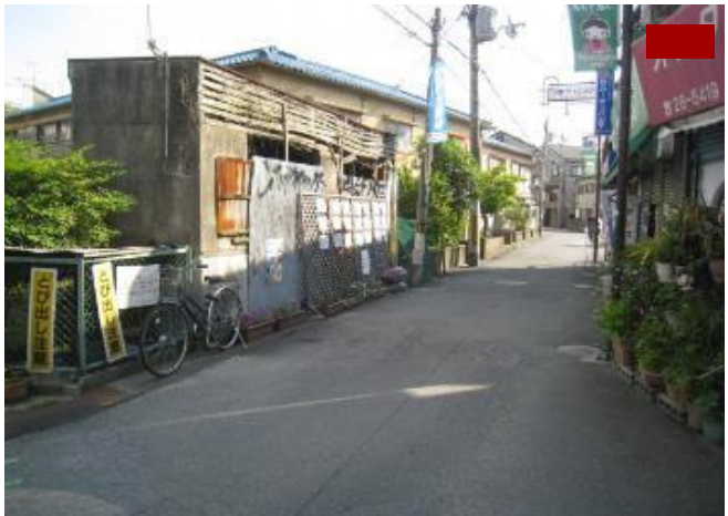
④密集住宅地区内の老朽木造住宅
