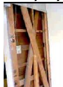
筋交いの新設
