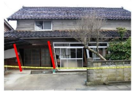
2 階部分が沈み込み全体的に傾斜して 1 階部分が傾斜している 出典：既存不適格建築物に係る是正命令について（技術的助言）
