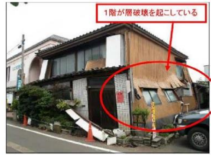
1 階部分が層状に破壊している 出典：「災害に係る住家の被害認定基準運用指針」（平成21年6月内閣府（防災担当））
