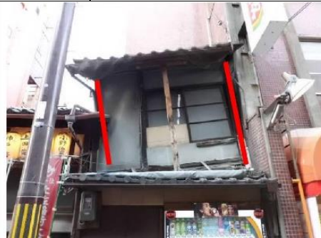
2 階部分が沈み込み全体的に傾斜して 1 階部分が傾斜している 出典：既存不適格建築物に係る是正命令について（技術的助言）
