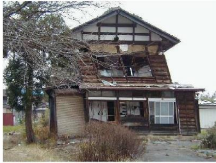
1 階部分が層状に破壊している 出典：「災害に係る住家の被害認定基準運用指針」（平成21年6月内閣府（防災担当））
