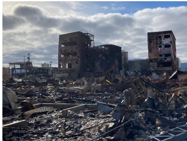
能登半島地震・輪島市朝市の被災状況(2024年1月1日)
