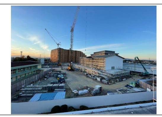
【撮影箇所】既存校舎屋上より【説明】 体育館棟 外装工事 校舎棟 基礎躯体工事(南工区)
