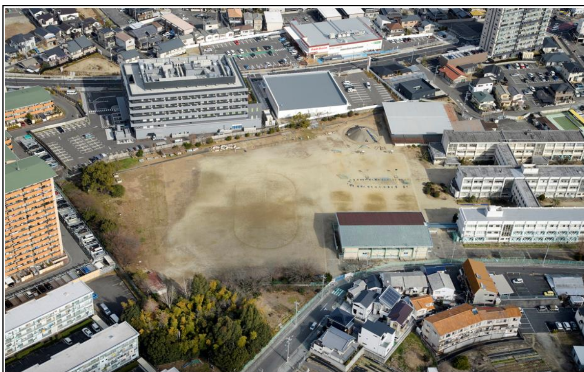
【全景(南側より)】 着工前の現場の様子です。
