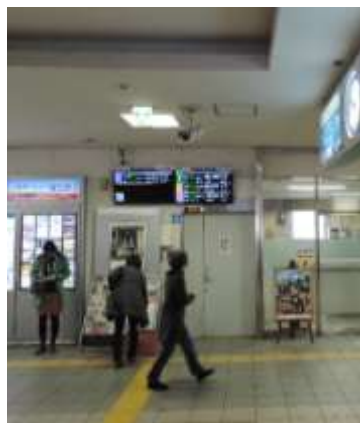
【改札口設置モニター】 《H26.3 設置》
