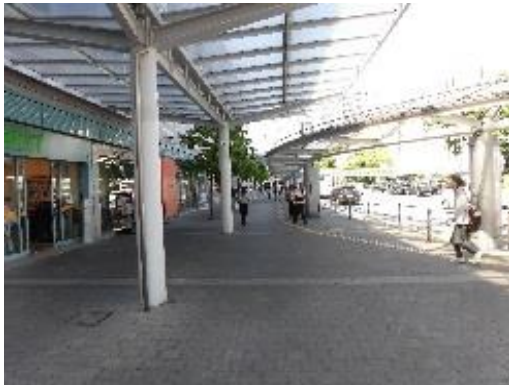
北側出入口付近の状況
