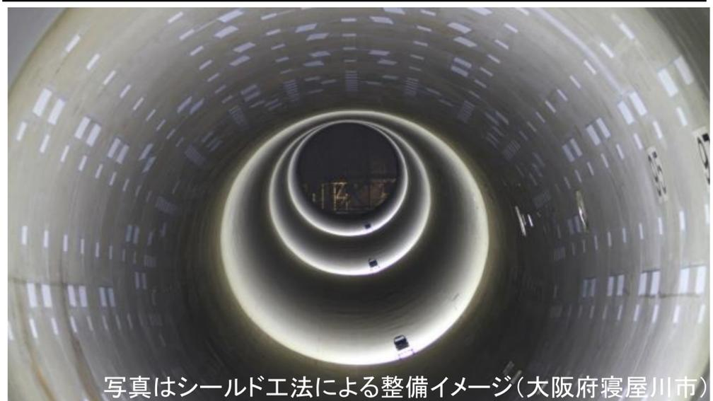
写真はシールド工法による整備イメージ(大阪府寝屋川市)
