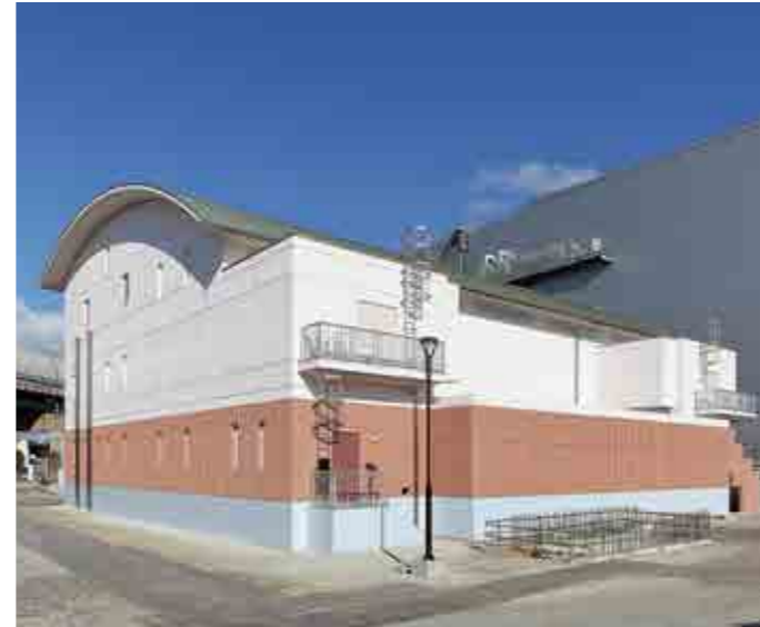
ポンプ棟外観
