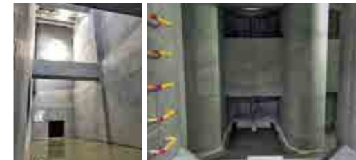
放流渠 吐口 ポンプ井
