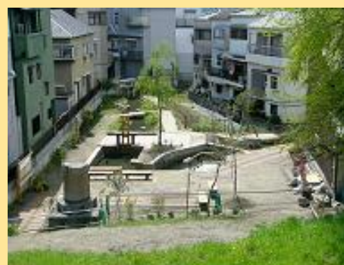
茨田樋遺跡水辺公園 H19(2007)年 4 月
