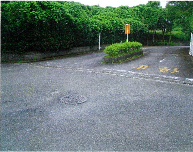
マンホール位置
