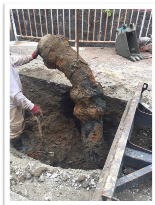
老朽化した水道管更新工事の様子
