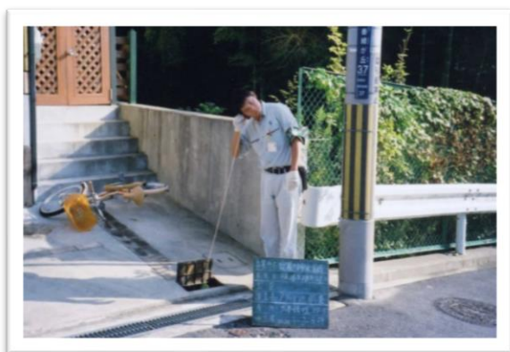
漏水調査の実施風景
