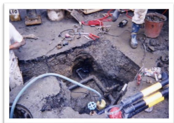
漏水の修繕風景
