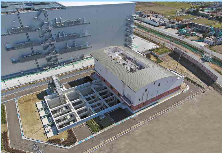
寝屋川市高宮ポンプ場
