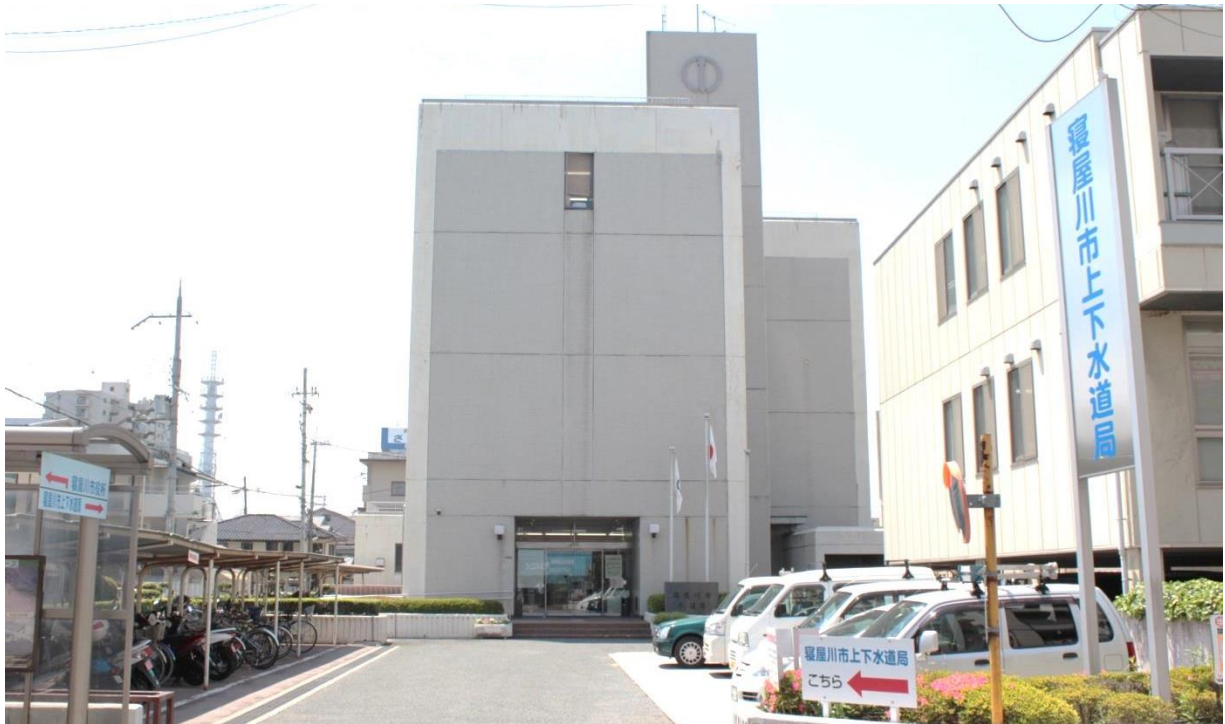
寝屋川市上下水道局庁舎
