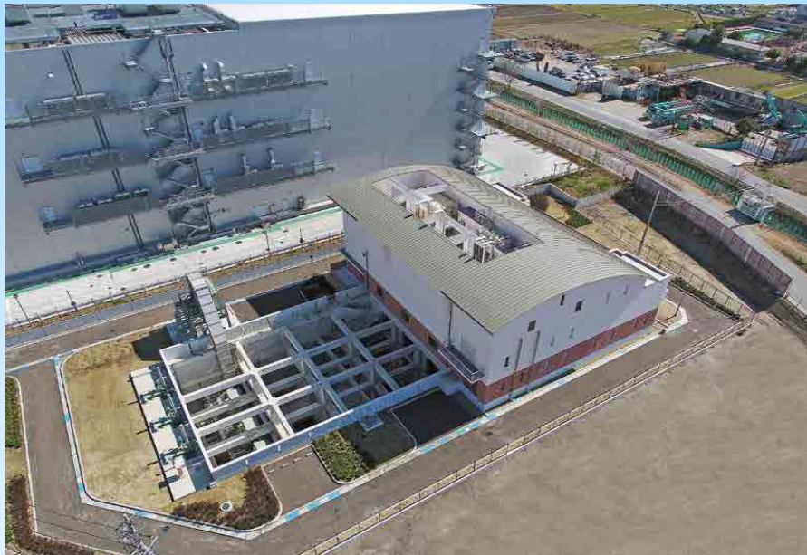
寝屋川市高宮ポンプ場
