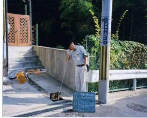
給水管付近の漏水調査
