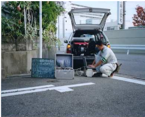
配水管の漏水調査
