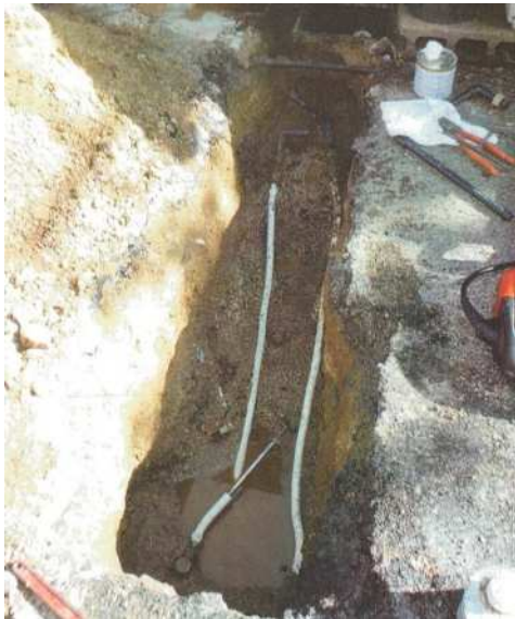
鉛管の布設状況
