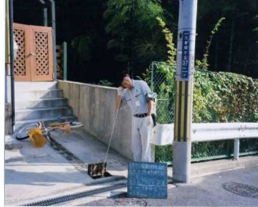
給水管付近の漏水調査
