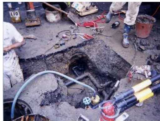
漏水箇所の修理工事
