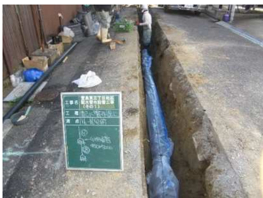
耐震化する経年管更新工事
