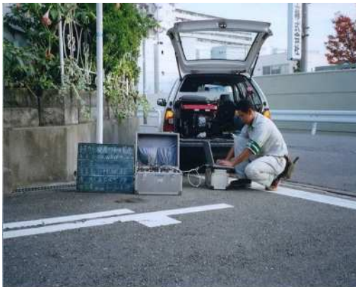
配水管の漏水調査
