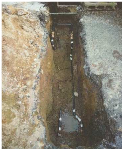
布設替え後の給水管
