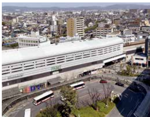
寝屋川市駅東口駅前広場
