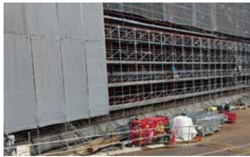
香里園駅の工事現場
