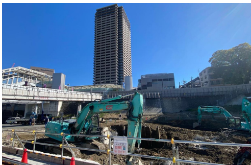
京阪本線連続立体交差事業・香里園工事現場
