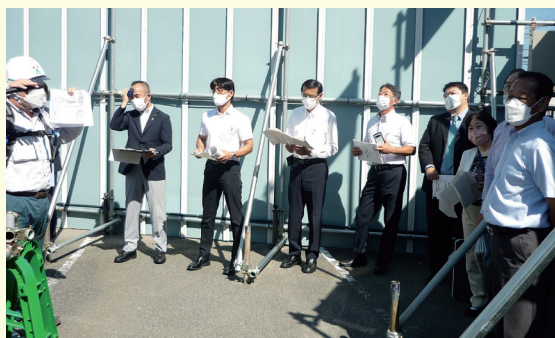
寝屋川市総合センター解体工事現場の視察の様子
