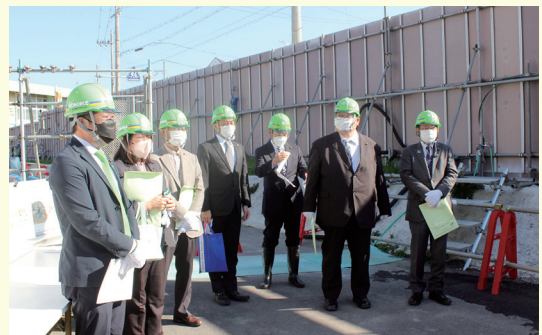
寝屋川市第四中学校区小中一貫校 施設整備工事現場の視察の様子
