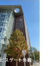
サービスゲート外観
