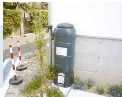
雨水貯水タンク設置例
