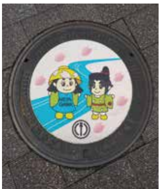
広告掲載を募集する下水道マンホール
