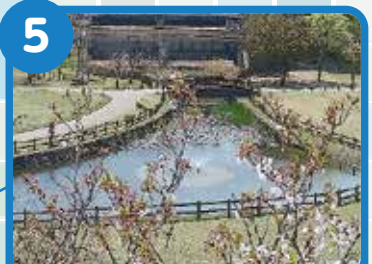
打上川治水緑地 越流部
