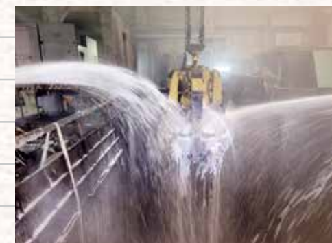
破砕施設内ピット
