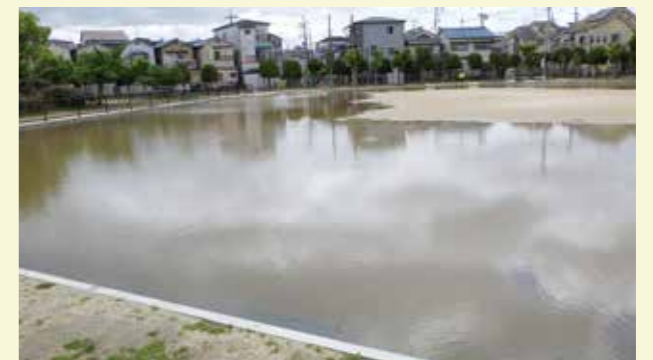
池田1号公園貯留施設の様子
