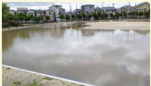
池田1号公園貯留施設の様子
