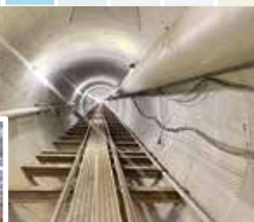
トンネル坑内
