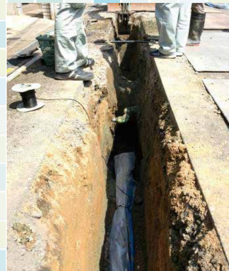
水道管工事の様子
