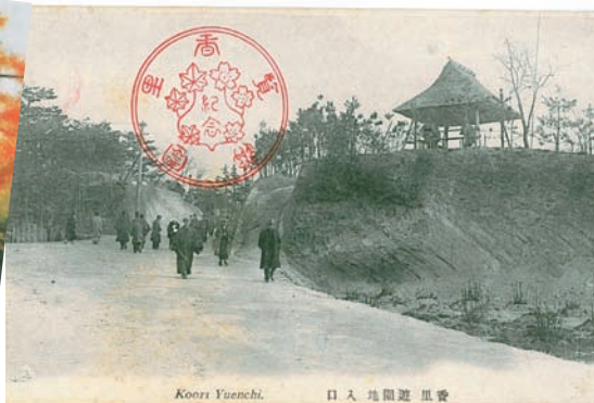
Koryu Yuenchi. 口入 地園遊里香
