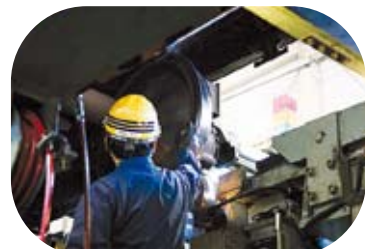
安全を守るための点検。
