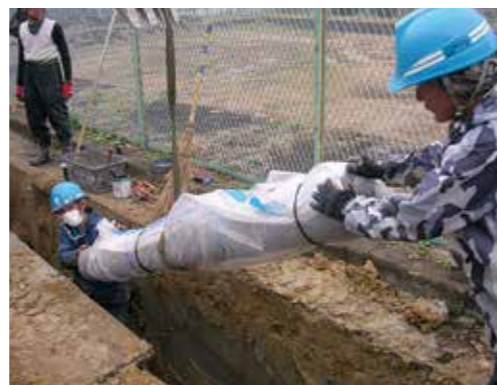
水道管を布設している様子
