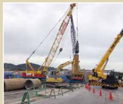
高宮ポンプ場整備事業
