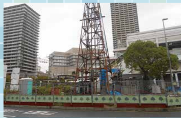
井戸設置工事
