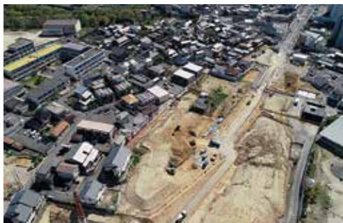
打上高塚町土地区画整理事業の工事の様子
