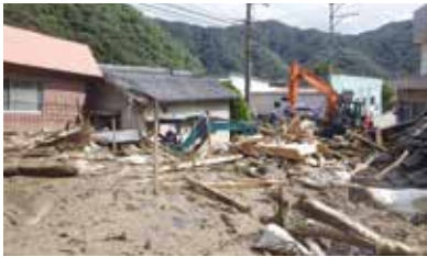
▲平成30年7月豪雨の被害 (広島県東広島市)
