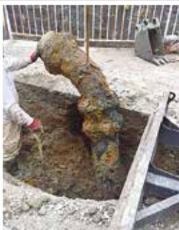
一般的な水道管の耐用年数は約40年といわれ、市内でも更新時期を迎える水道管は、年々増加しています。主に鉄からできている水道管は、古くなると取り巻く土壌の環境などにより腐食し、穴が空くなどのおそれがあります。水道管を取り替えるための工事には多額の費用が必要ですが、将来にわたって、安全な水を安定して届けるために、計画的に工事を実施しています。
