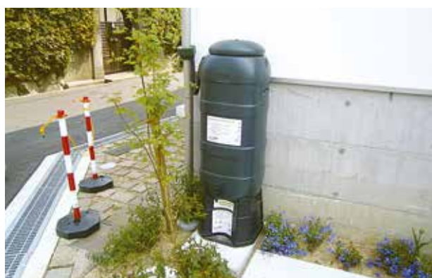
雨水貯留タンクの設置
