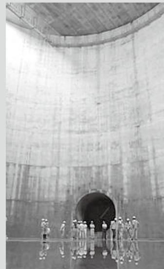
府が寝屋川流域の浸水対策として、平成21年から南寝屋川公園で進めてきた「寝屋川北部地下河川立坑」が完成しました。同地下河川は門真調整池(7万㎡)として27年6月から供用しており、市と門真市、大東市にまたがる約1100haの浸水被害が軽減されます。
