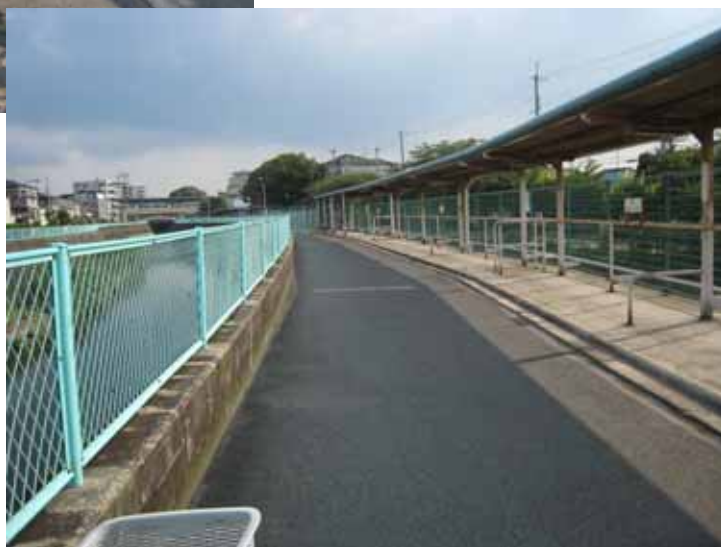
駅から少し離れた駐輪所の状況
