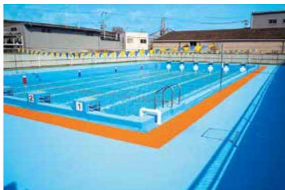
公立中学校における改修後のプール
