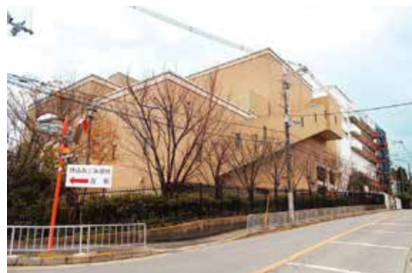
クリーンセンターの外観
