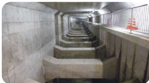
仁和寺調節池の内部
