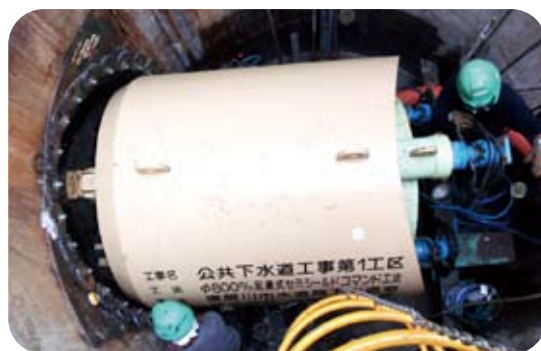
公共下水道工事
