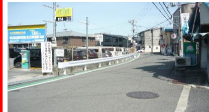
ガードレールの設置
