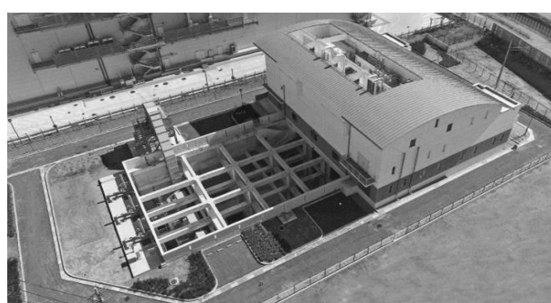
【図表 13 高宮ポンプ場】
