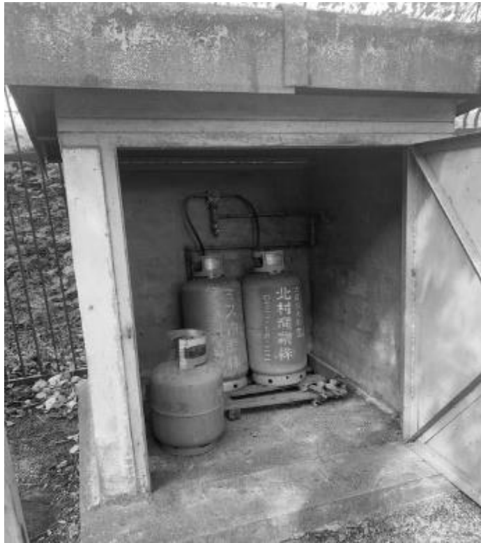
【図表 84 南前川ポンプ場の屋外倉庫】
