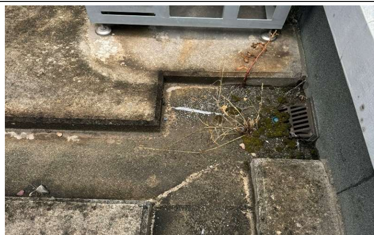
【屋上ドレン（排水溝）】
