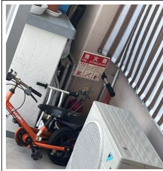
【通路の消火器】
