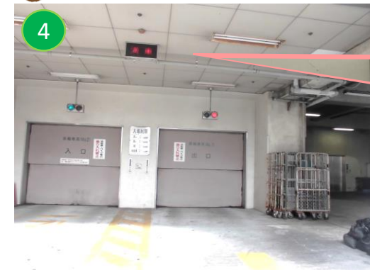
アドバンスねやがわ直結 地下駐車場 (カーリフト)
